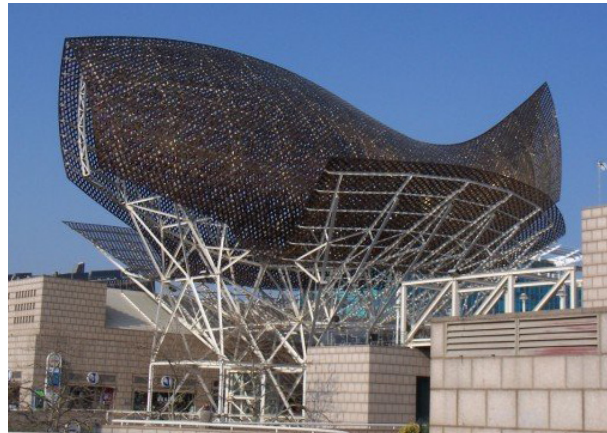
Peix d'Or - Frank Gehry, Port Olímpic, Barcelona, Spain
