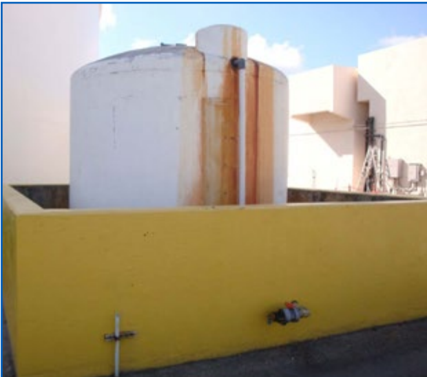
Verifique que la válvula de drenaje no tiene fugas y que esta cerrada cuando no esta en uso
