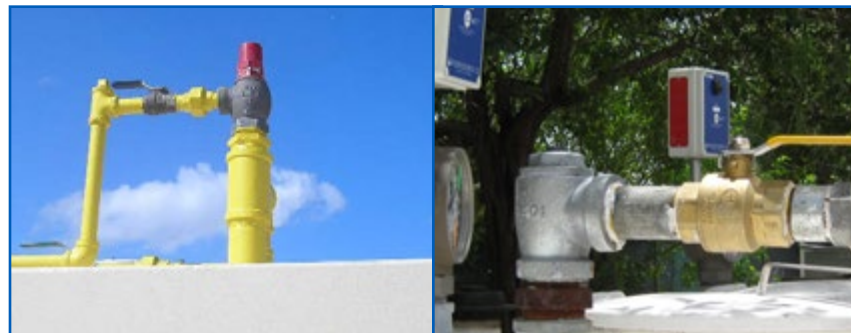
Válvula anti-sifón con válvula de aislamiento
