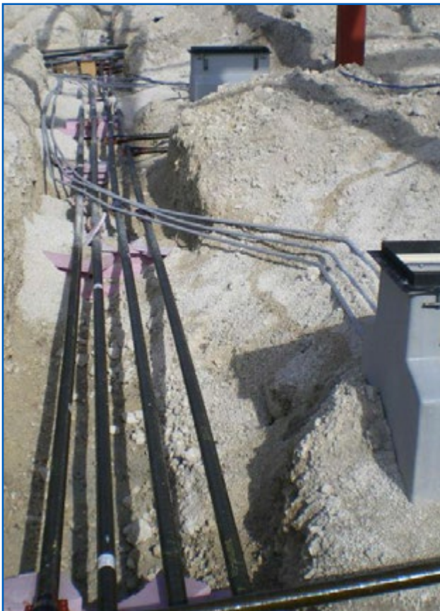
Instalación de tubería y dispensadores para sistema UST
