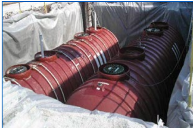
USTs de fibra de vidrio durante la instalación
