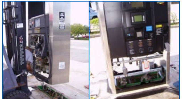
Instalación de dispensador
