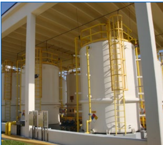
Verifique la integridad del techo, especialmente después de una tormenta
