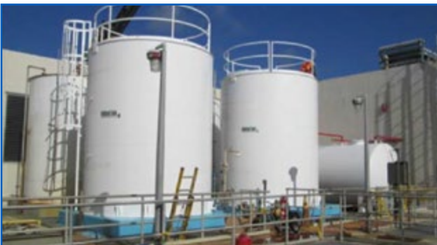
AST vertical de acero de pared doble
