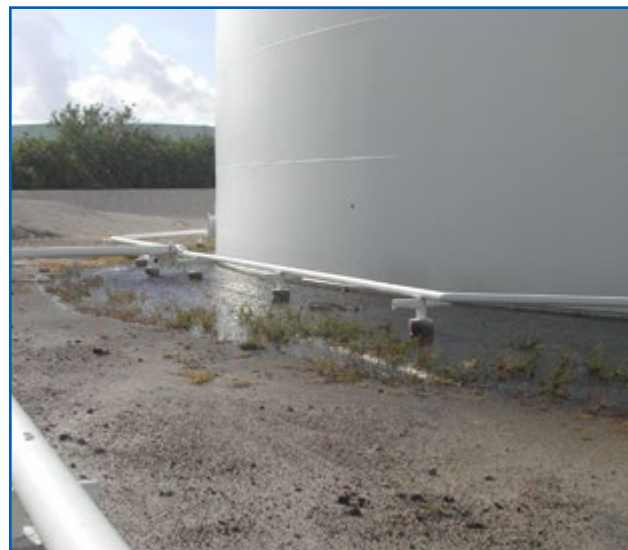
Verifique la contención por fugas o acumulación de liquido
