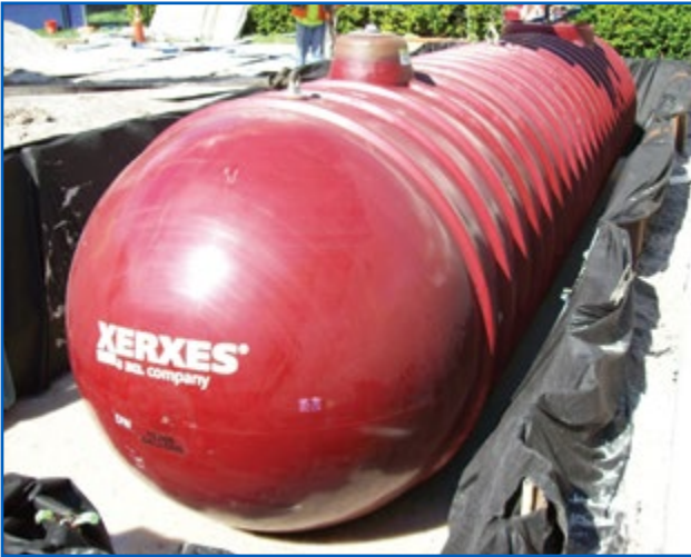
UST de pared doble de fibra de vidrio con intersticio lleno de agua salobre
