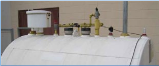
AST de pared doble con cubo de derrame, sifón y detector de fuga
