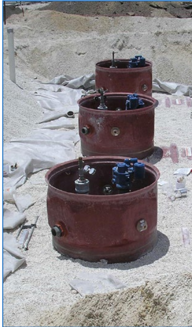
Instalación de sumidero de la bomba
