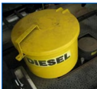
Cubo de derrame y tubería de sbastecimiento remoto
