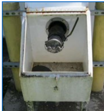
Cubo de derrame y tubería de sbastecimiento remoto
