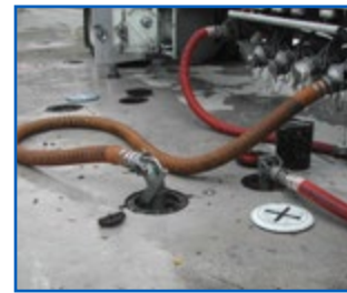
Camión surtidor de petróleo llenando un UST
