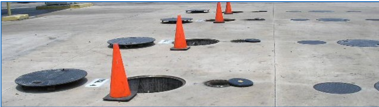
UST con cobertura abierta de los sumideros para una inspección
