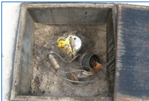
Sonda electrónica discriminante extraída para ser reemplazada
