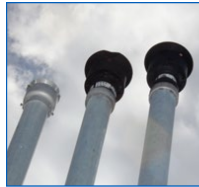
Tubería de ventilación extendida 12 pies
