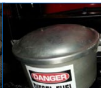
Cubo de derrame y tubería de sbastecimiento remoto
