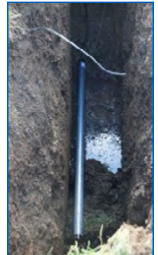
Ánodo instalado de sacrificio
