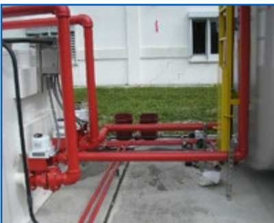
Tubería para AST fabricados en taller
