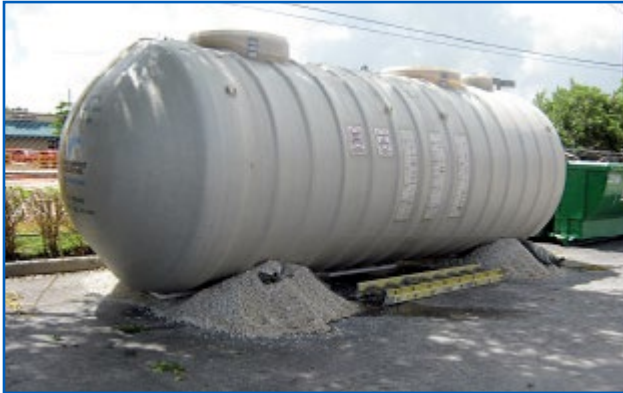
UST de fibra de vidrio antes de su instalación
