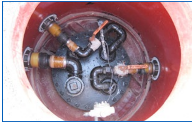
Bota de entrada con conexión de prueba
