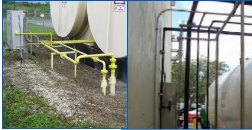
Tubería elevada de pared simple que transiciona a tubería de pared doble subterránea
