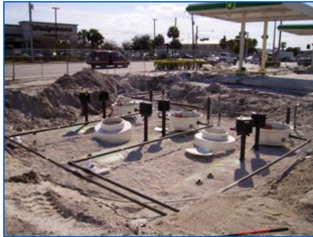
Esquema de tubería de fibra de vidrio de pared doble
