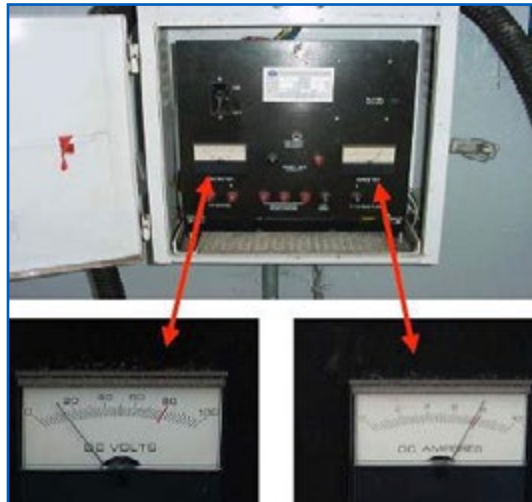
Rectificador para corriente impresa que mide amperios y voltios
