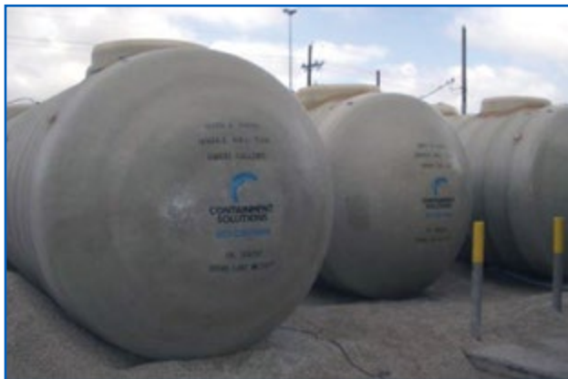
USTs de fibra de vidrio antes de la instalación
