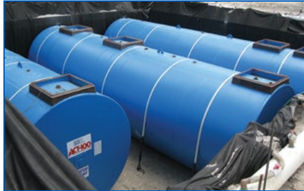
UST de acero con cobertura de fibra de vidrio durante la instalación
